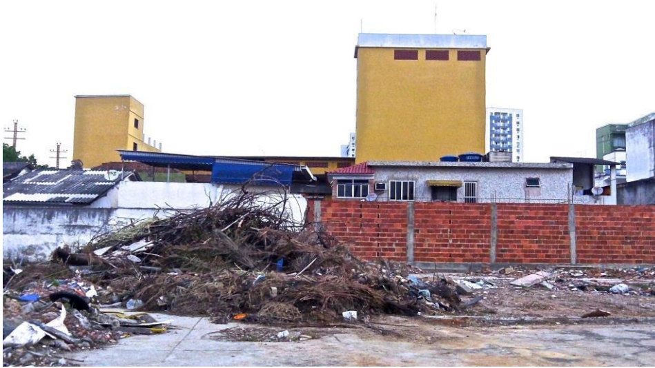
Fotografia 12: “Teatro Municipal Demolido”
