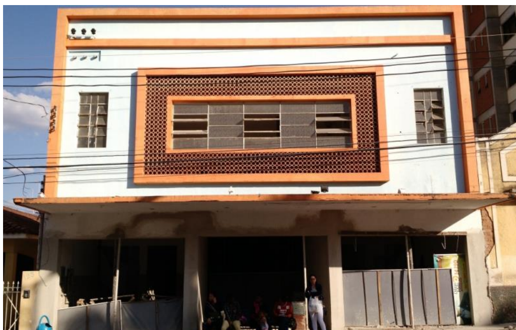
Figura 9 – Fachada do Cine Rex em 2017. Edificação em processo de demolição.
